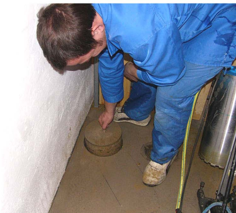
Bohrkern entfernen
