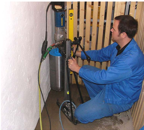
Bohrkrone senkrecht stellen
