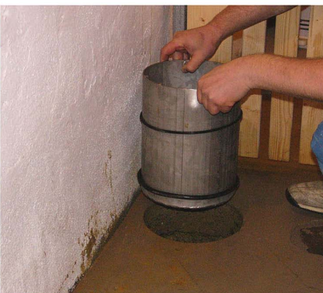
Behälter mit Rollringen einbauen und fixieren
