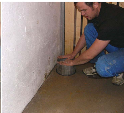
Behälter mit Rollringen einbauen und fixieren
