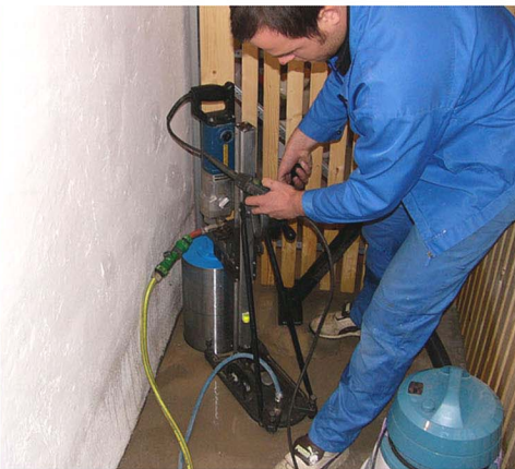
Bohren bis Einbautiefe
